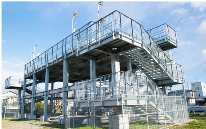
↑静岡市駿河区用宗にある津波避難タワー。このエリアでは最大12mの津波が予想されている。
